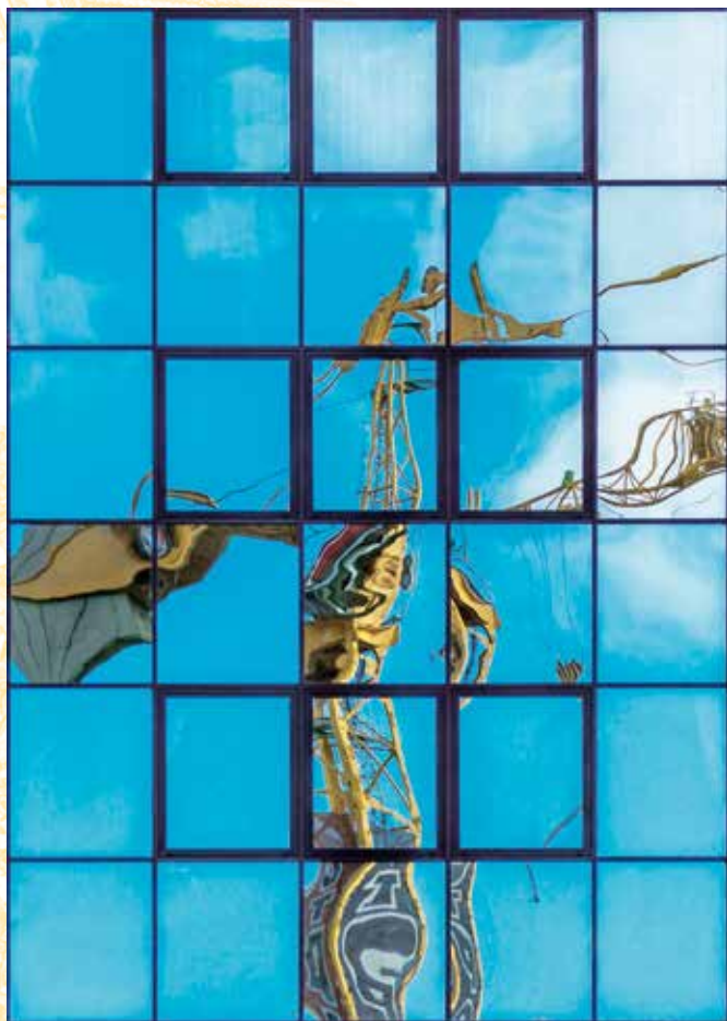
Figure 2 : Déformation de l'image réfléchie par le vitrage
