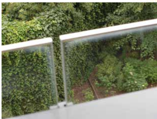
Figure 1 : Blanchiment lié au contact avec une colle incompatible (bord supérieur) et l'humidité (bords latéraux)
