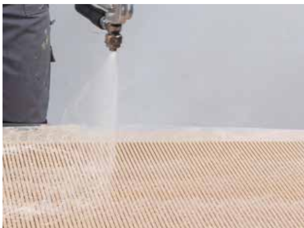
Application doublage 1 : même surfaces rugueuses et poreuses
