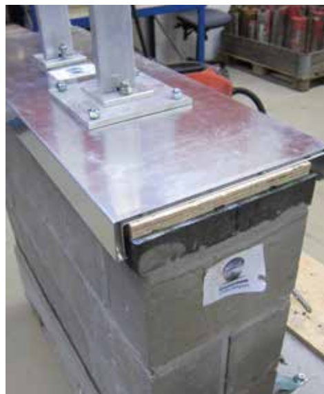
Photo 4a : construction sur chaperon de mur
