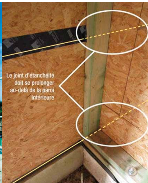
Fig. 4 – Raccord étanche à l'air entre une paroi intérieure et une paroi extérieure avec une membrane (à gauche) et avec un revêtement continu en panneaux (à droite)
