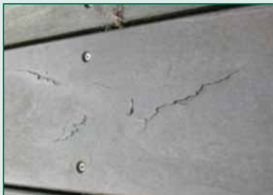
Fig. 2 Délitement de la surface du bois
