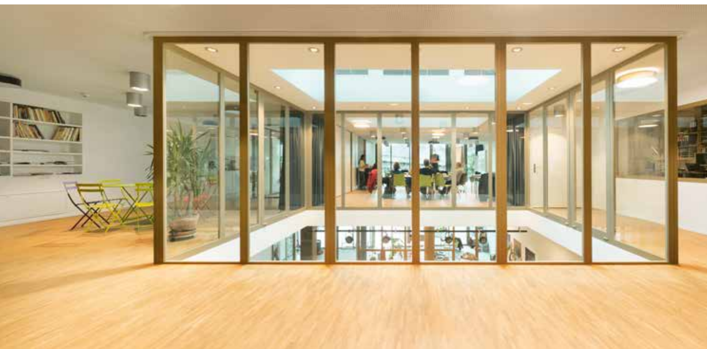
CONTRAFLAM® EI60 dans un profil en bois
