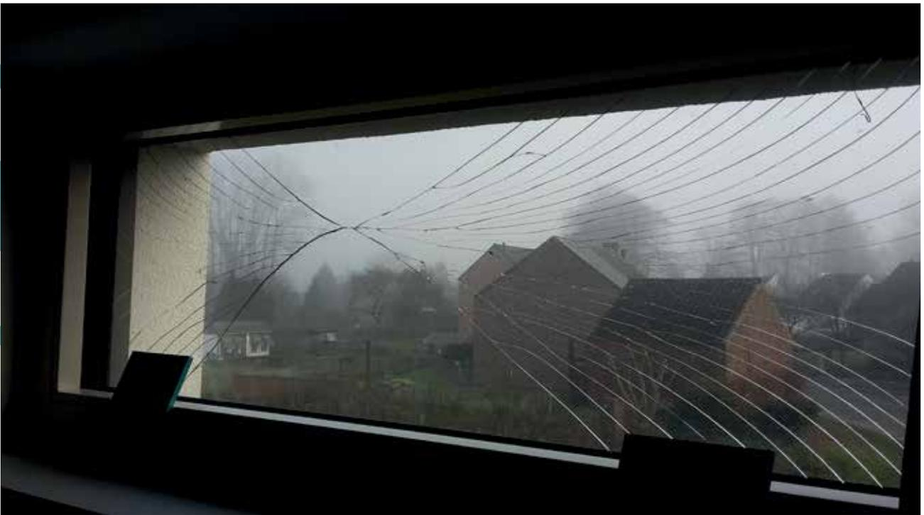
Fig.1: Type de casse d'un vitrage isolant de petites dimensions fréquemment observé durant les périodes hivernales anticycloniques.
