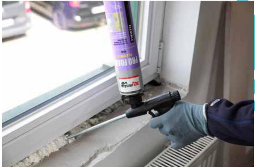
Elle convient parfaitement à la réalisation de joints dans le cadre de l'installation de fenêtres conformément aux réglementations PEB et pour éviter les ponts thermiques.
