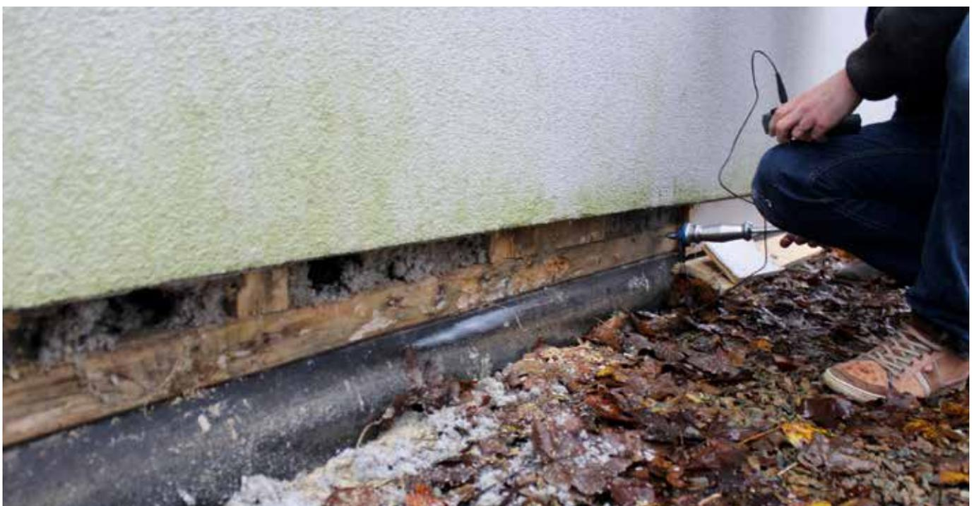
Fig 1 | Analyse des dégradations en pied de mur
