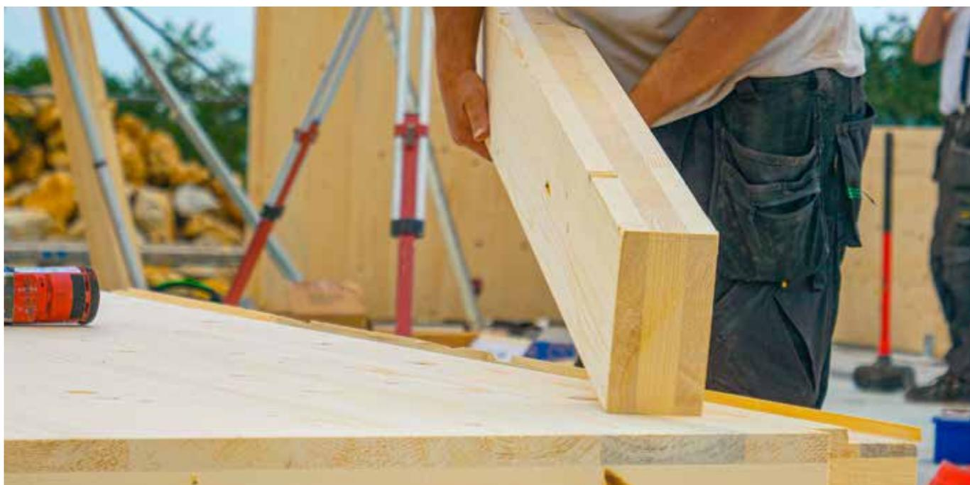
(\*) Le CLT est un produit de construction composé de panneaux en bois massifs, collés en couches croisées.
