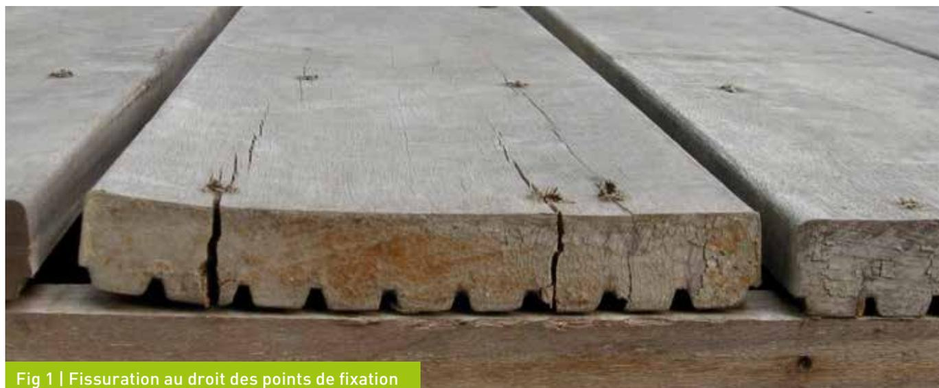
Fig 1 | Fissuration au droit des points de fixation
