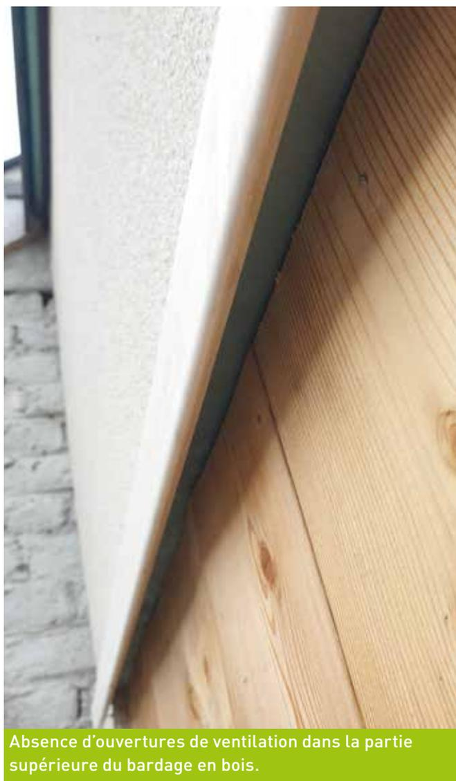
Absence d'ouvertures de ventilation dans la partie supérieure du bardage en bois.
