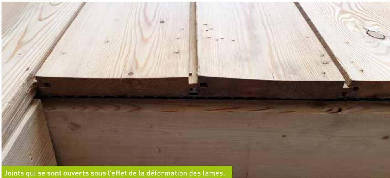
Joints qui se sont ouverts sous l'effet de la déformation des lames.
