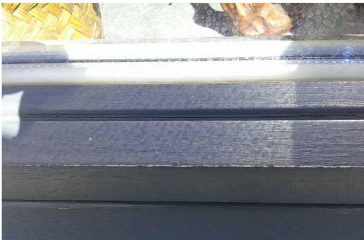
**Bord châssis : L'arrondi présente un rayon de courbure insuffisant, entraînant l'interruption du film de peinture, à l'origine du décollement du film à partir de cet endroit.**
