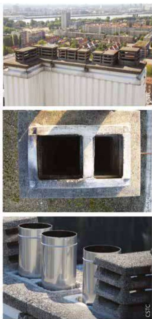
fig. 9 | Illustration d'un conduit collectif de type shunt.
