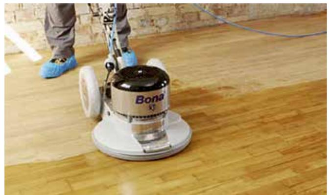
Première étape : un nettoyage en profondeur à la machine comme une autolaveuse (Bona PowerScrubber) et un produit de nettoyage approprié (Bona DeepClean W). Le but est d'éliminer les salissures les plus tenaces et de rafraîchir la surface, sans risque de décolorer le bois.
