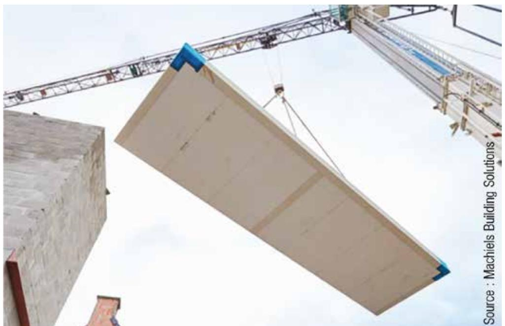
1. Le système constructif innovant à ossature en bois préfabriqué étudié permet d'obtenir des performances acoustiques in situ particulièrement bonnes. (photo : Machiels Building Solutions)
