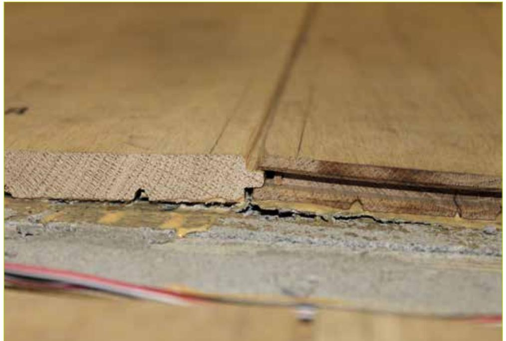
2 | Rupture adhésive entre la colle rigide et le support en raison de conditions trop sèches
