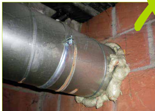
Fig. 4 En haut : les ouvertures sont resserrées à la laine de verre et non à la laine de roche ; de plus, les ouvertures sont trop grandes par rapport au diamètre des câbles. En bas : resserrage non conforme (mousse) d'un conduit de ventilation ; un clapet résistant au feu doit être mis en œuvre.
