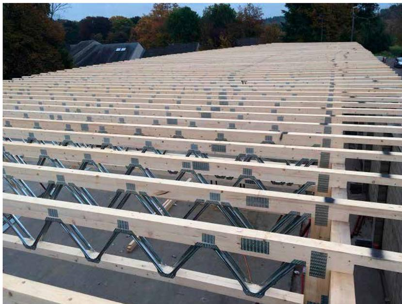
Elle présente de multiples avantages. Elle est très légère et facile à manipuler et à mettre en œuvre sur chantier (ne pèse que 40 % du poids d'une poutre massive). Les poutres sont conçues sur mesure et optimisées par informatique et elles s'adaptent donc à chaque projet de construction. Outre leur transport et mise en œuvre faciles, elles permettent aussi de faire passer des gaines et conduits.
