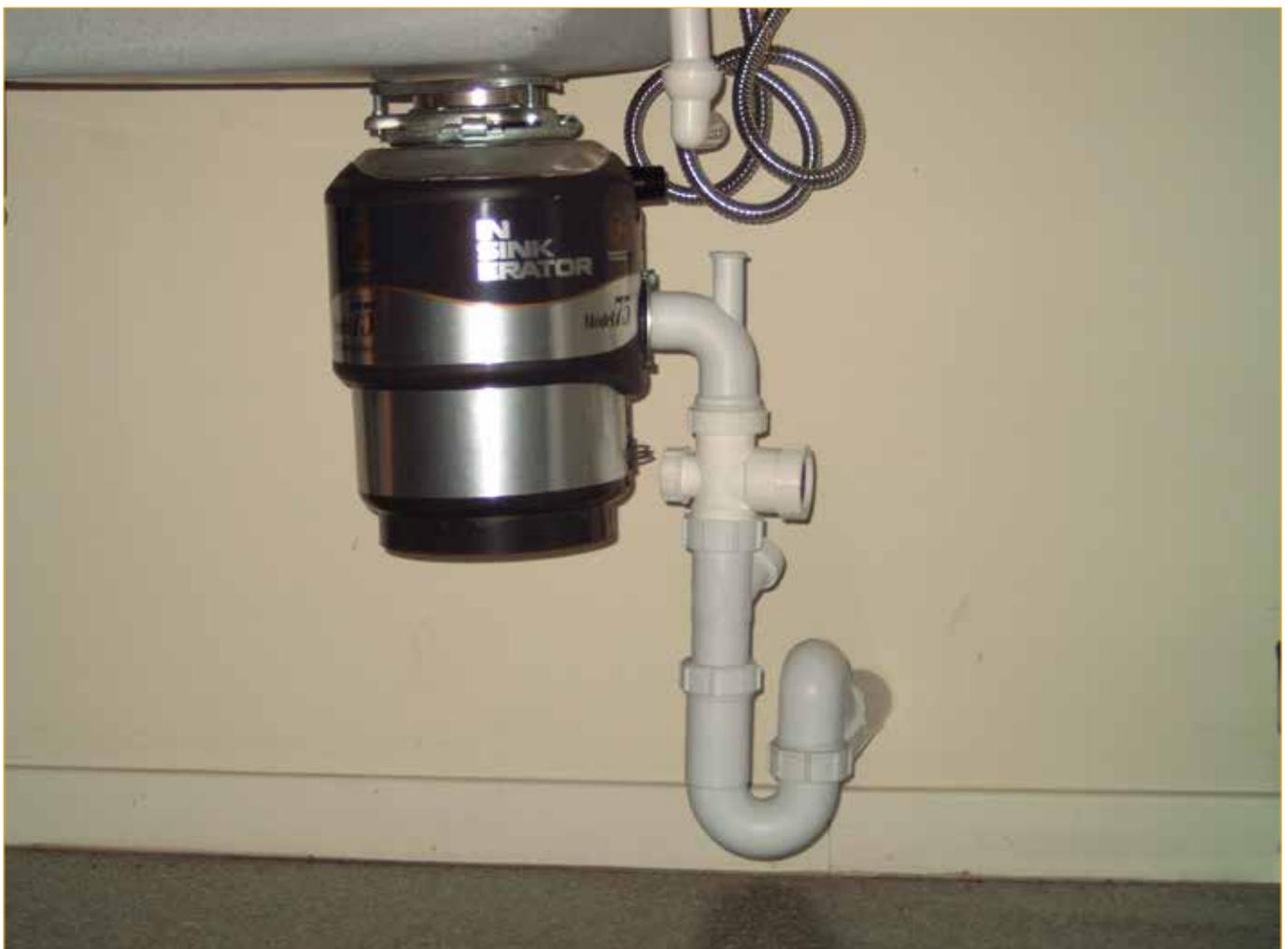
La pente nécessaire est aussi à respecter pendant l'installation des décharges. Une pente contraire - vers le broyeur - sera néfaste pour la bonne utilisation. Le branchement du lave-vaisselle se fait sur la courbe du broyeur et reste hors de la chambre de broyage. Le trop-plein peut être directement raccordé au tuyau sur le côté de l'appareil.
