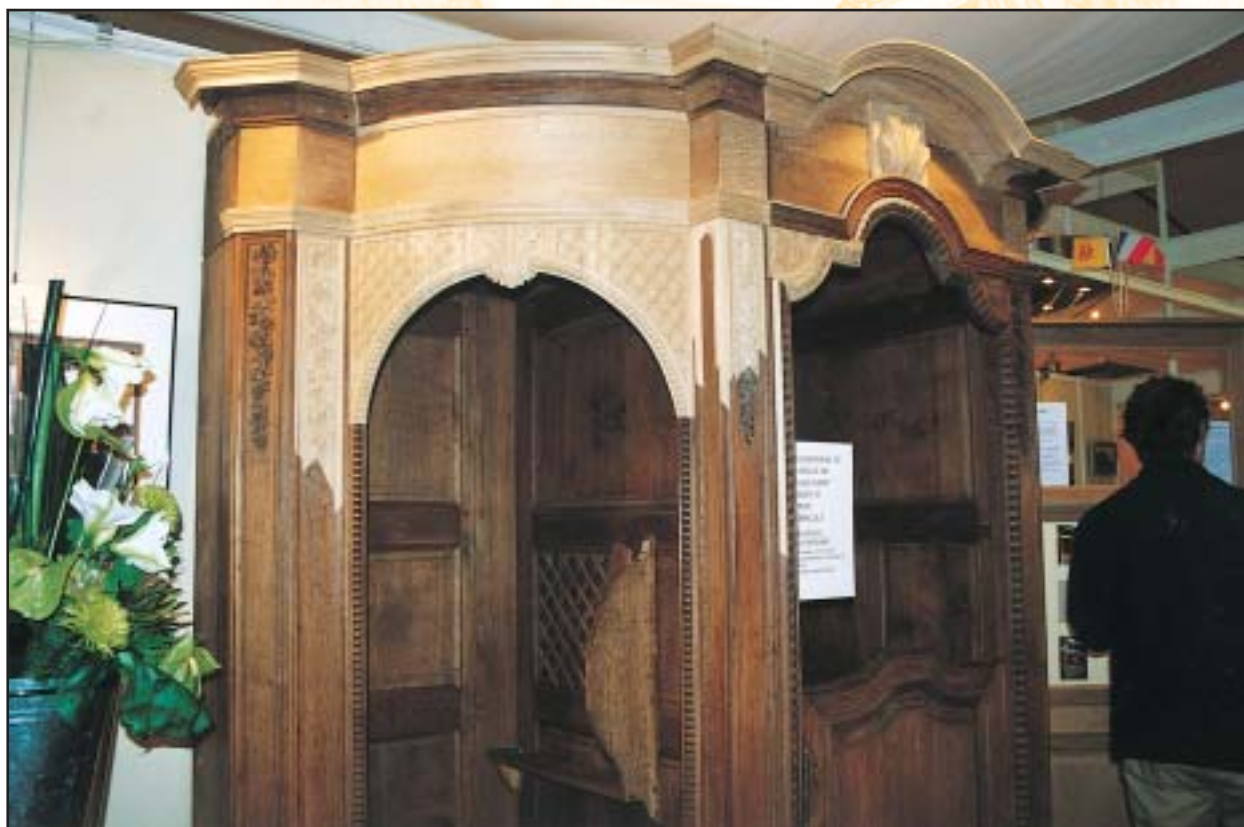
Restoration du confessionnal de l'Eglise de Gleische (Flémalle)
