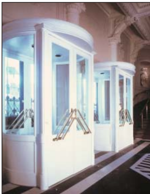
Théâtre de la Monnaie. Restauration des menuiseries intérieures et extérieures en bois.
