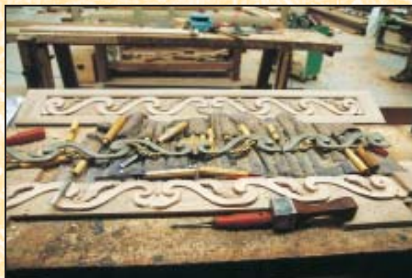
Château de Seneffe. Travail de sculpture sur des menuiseries en bois de chêne.
